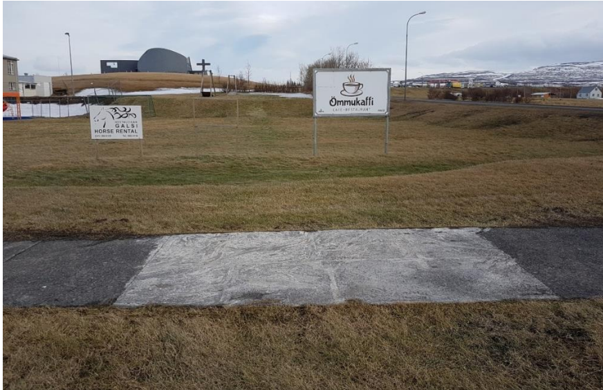
Mynd 3. Dæmi um umhverfisfrágang á lagnaleið stofnlagnar
